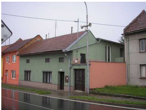
Uliční pohled na RD.
